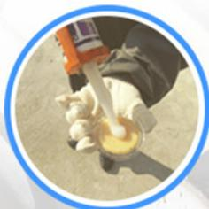
Após a lavagem, antes de proceder à colagem dos pratos de ExcaliBird, as superfícies devem estar completamente secas afim de assegurar a aderência da cola ou silicone.
